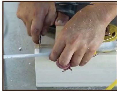
Bước 1: Cắt khung bao đúng theo chiều cao đo đạc
