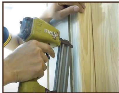
Bước 7: Căn chỉnh lắp cây khung bao còn lại
