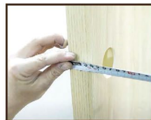
Bước 12: Lắp đặt tay nắm cửa và phụ kiện
