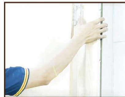
Bước 6: Lắp cánh lên cây khung bao đã bắn lên tường
