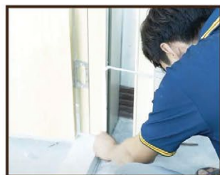
Bước 10: Đo cắt nẹp viền và gắn nẹp vào khung bao
