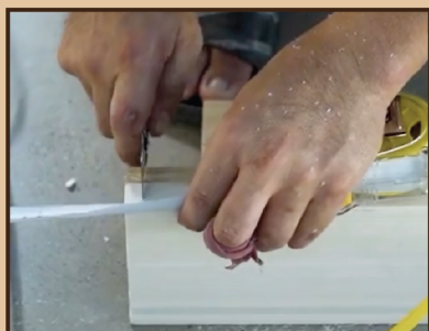
Bước 1: Cắt khung bao đứng theo chiều cao đo đạc
