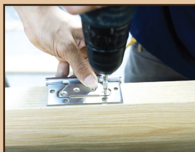
Bước 5: Bắn 3 bản lề vào cánh cửa theo đúng khoảng cách quy định
