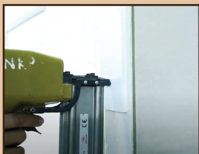
Bước 4: Lắp cây khung phía bên bản lề trước
